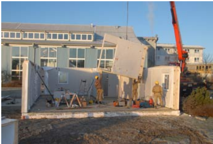
Il montaggio di una casa prefabbricata in cantiere
